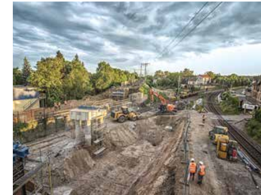
MANNHEIM KREUZUNGSBAUWERK (2016-19) Erneuerung von zwei Kreuzungsbaupunkten im Schutze der zu erstellenden 2er-, 4er- und 5er-Hilfsbrückenketten
