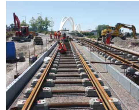
STRASSBURG - KEHL (2016-18) Neubau einer festen Fahrbahn (Meterspur) für die Straßenbahn von Strassburg nach Kehl
