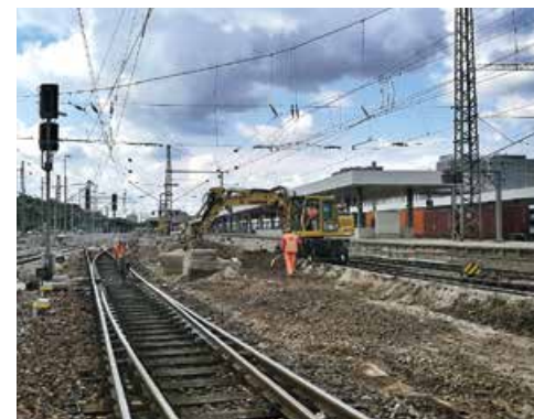
HAUPTBAHNHOF MANNHEIM (2014-17) Neubau eines barrierefreien Bahnsteigs, Verlängerung der Personenunterführung, Kabeltiefbau- und Kabelverlegearbeiten
